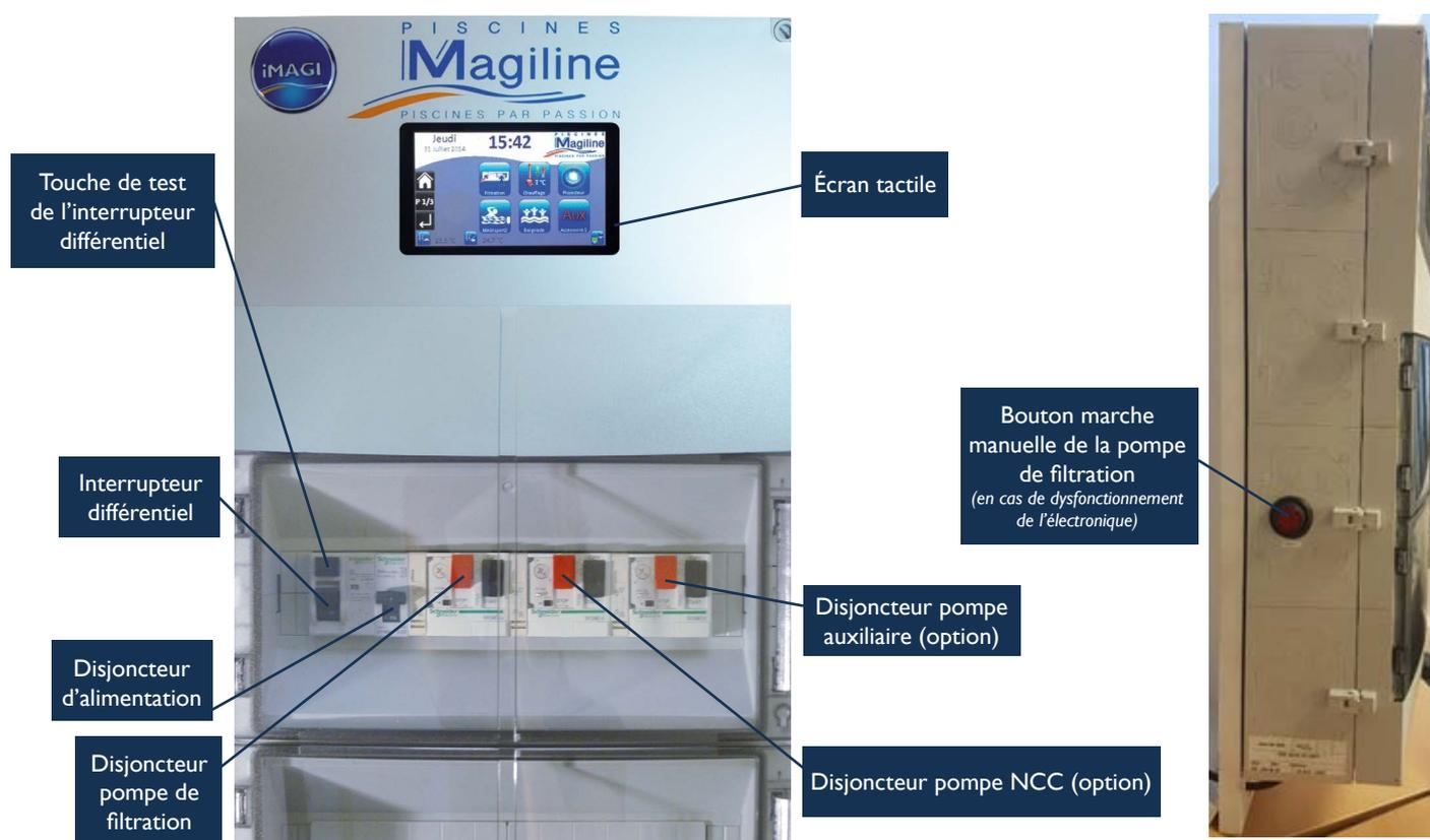
**Pour mettre sous tension** votre coffret de pilotage iMAGI, armez l'interrupteur différentiel et le disjoncteur d'alimentation.
